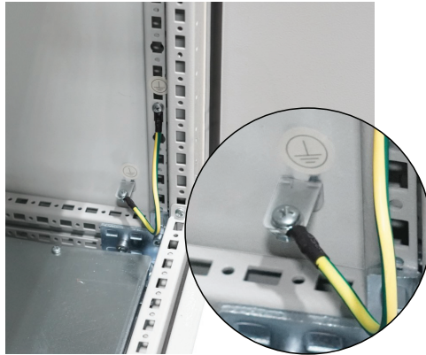
Sabit kapaklar üzerinde ilave koruma iletkeni bağlantı ucu
